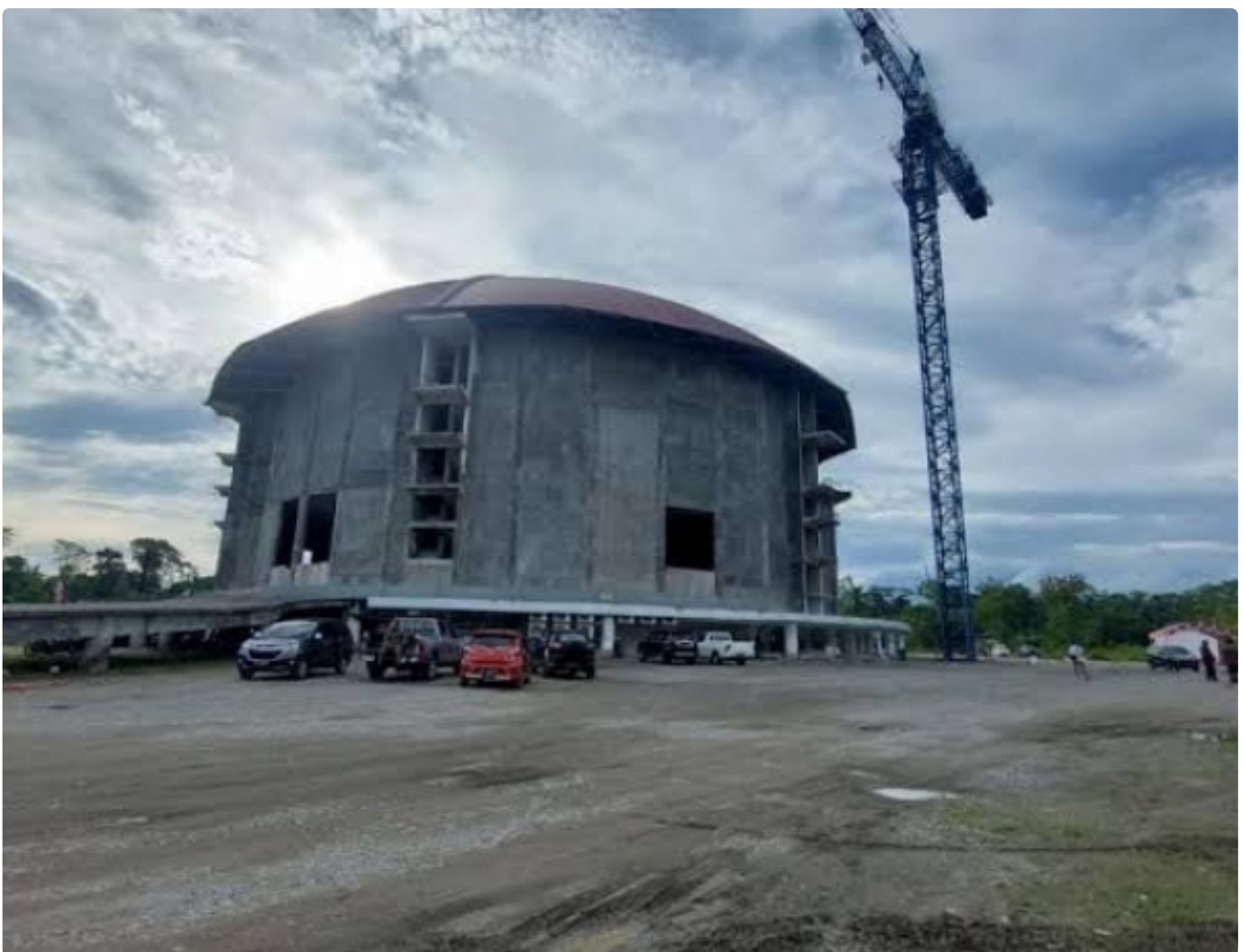
Pembangunan Gereja Kingmi Mile 32
